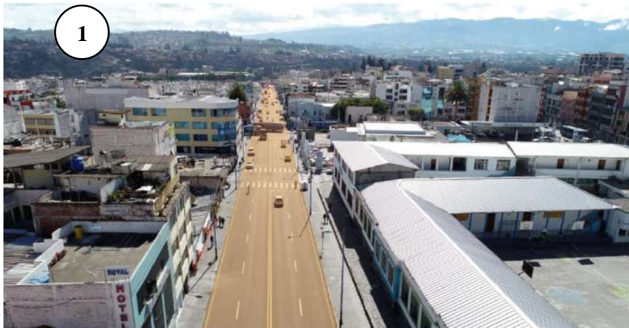
Ilustración 86: Eje comercial de la Av. Cevallos Fuente: Recorrido por el sitio
