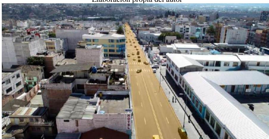
Ilustración 99: Eje seleccionada para conteo vehicular y peatonal / Av. Cevallos Elaboración propia del autor
