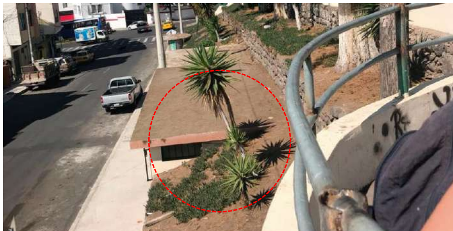
Ilustración 41: Las baterías sanitarias no funcionan Fuente: Recorrido en el sitio
