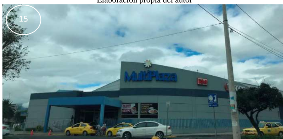
Ilustración 33: Centro Comercial MultiPlaza Fuente: Recorrido por el sitio Elaboración propia del autor
