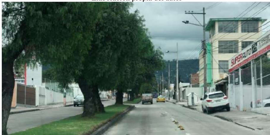
Ilustración 5: Condición vial del eje de la Av. Las Américas Fuente: Recorrido por el sitio Elaboración propia del autor
