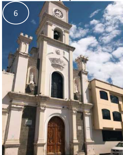
Ilustración 24: Iglesia la Merced Fuente: Recorrido por el sitio Elaboración propia del autor
