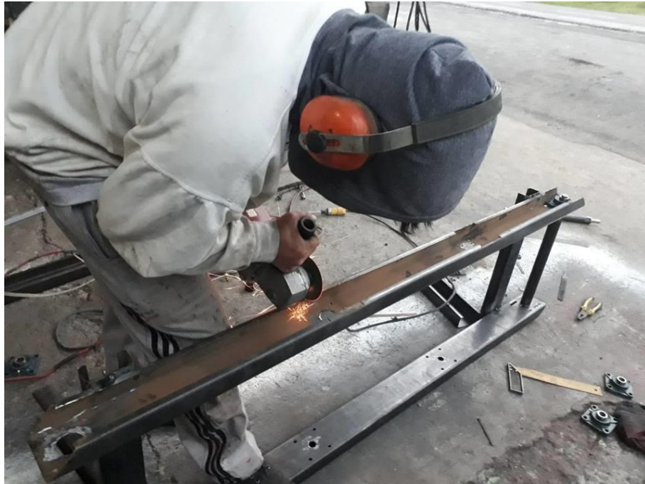
Anexo 5 Perforado de agujero en perfil metálico para colocación de chumaceras.
