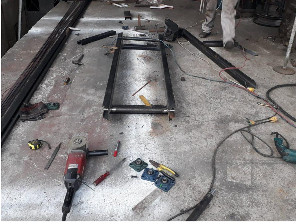
Anexo 7 Colocación de los rodillos en la estructura.
