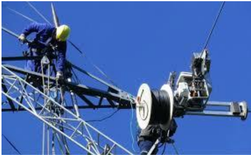
GRÁFICO 4. TENDIDO DE CABLE DE FIBRA ÓPTICA.
