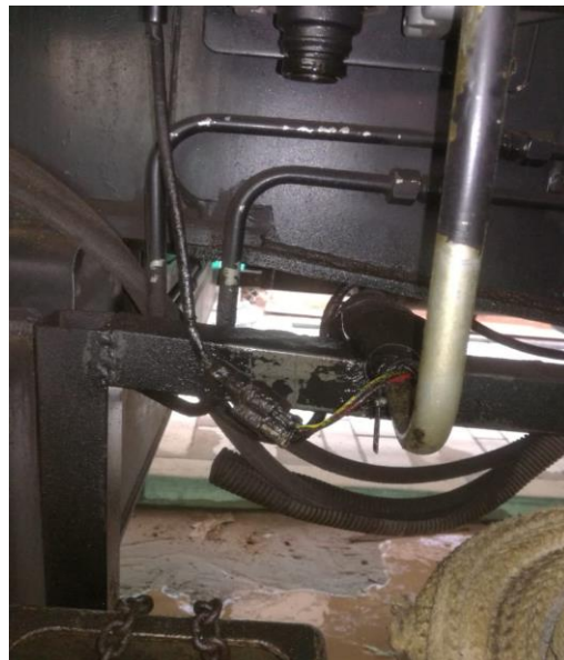
Figura N° 3: Cañería del fluido hidráulico
