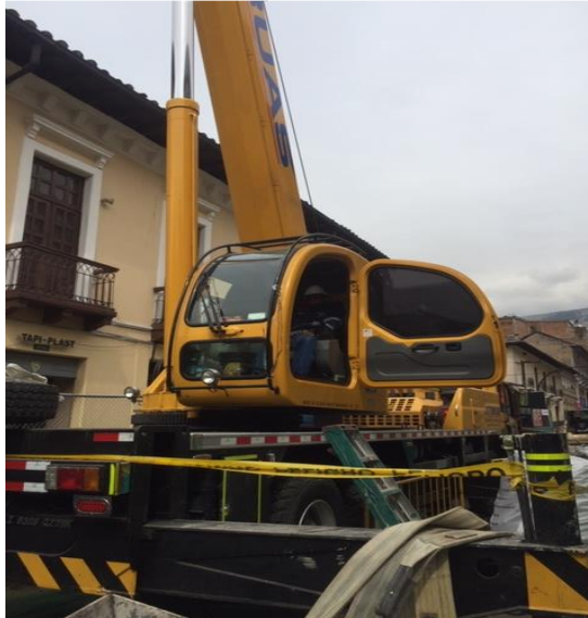
Figura N° 2: Grúa Telescópica XCMG
