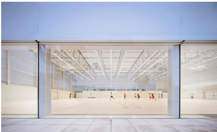
Imagen 21. Cobertura de vidrio traslucido Fuente: Javier Callejas – CAMPO BAEZA
