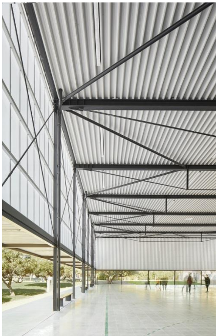
Imagen 17. Estructura – Pabellón Deportivo Municipal de Vila-Seca Fuente: José Hevia – NAM Arquitectura
