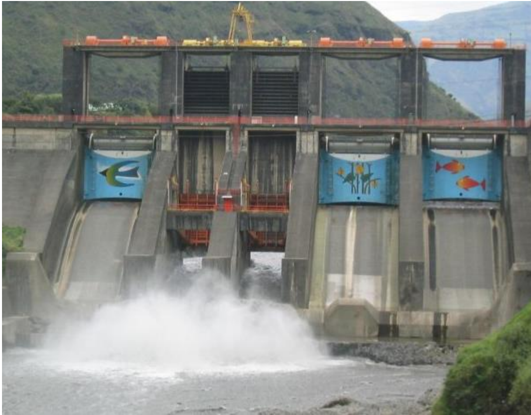
Imagen 3. Desagües de Fondo Fuente: Hidroagoyán (Robayo, 2019)
