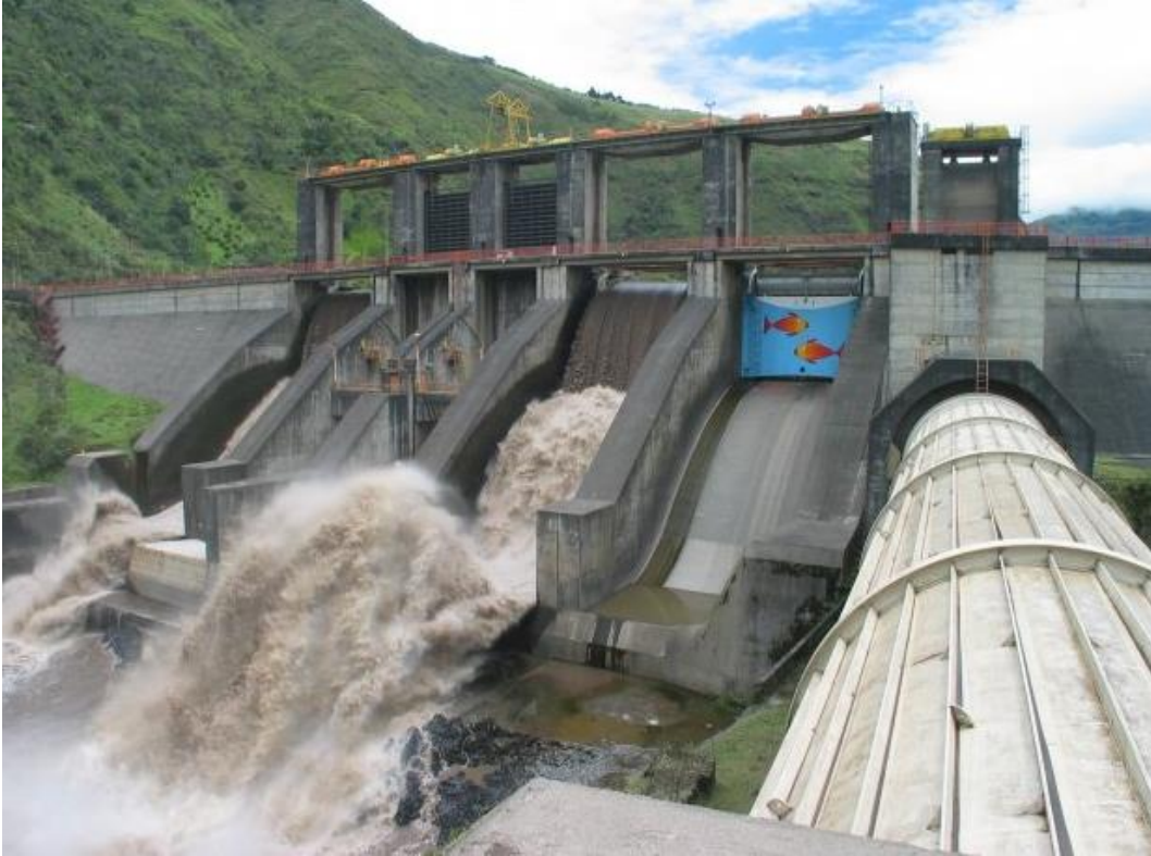
Imagen 2. Vertedero Fuente: Hidroagoyán (Robayo, 2019)
