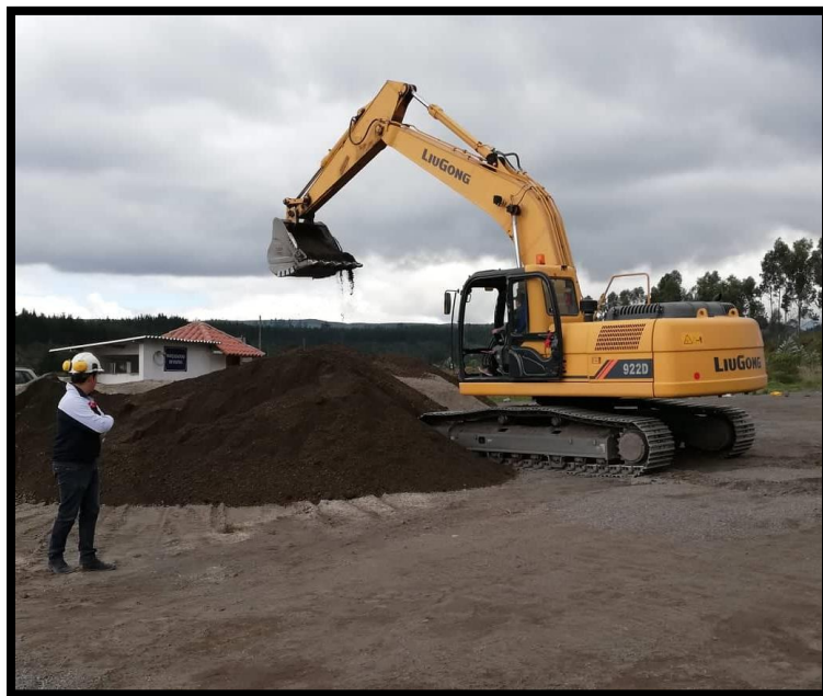
IMAGEN 1. ÁREA DE TRABAJO: EXCAVADORA.
