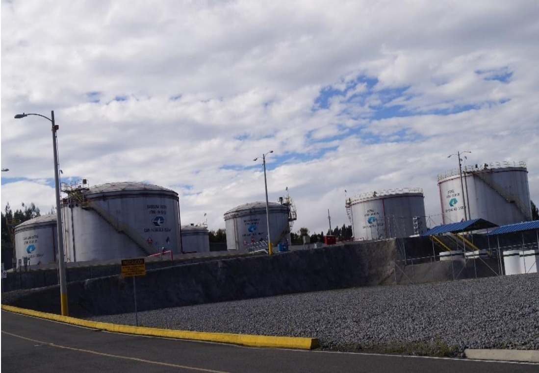
Figura No. 6: Tanques de Almacenamiento del Terminal de Productos Limpios Riobamba EPP
