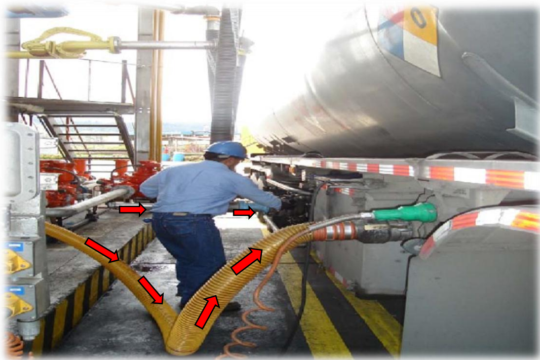
Figura No.11: Sistema de Carga Ventral en el Terminal de Productos Limpios Beaterio de EP Petroecuador Fuente: Investigación de campo en el Terminal de Productos Limpios de EP Petroecuador 2018; (TERMINAL DE PRODUCTOS LIMPIOS BEATERIO EP PETROECUADOR , 2010); (ARTEAGA PUGA, 2010)
