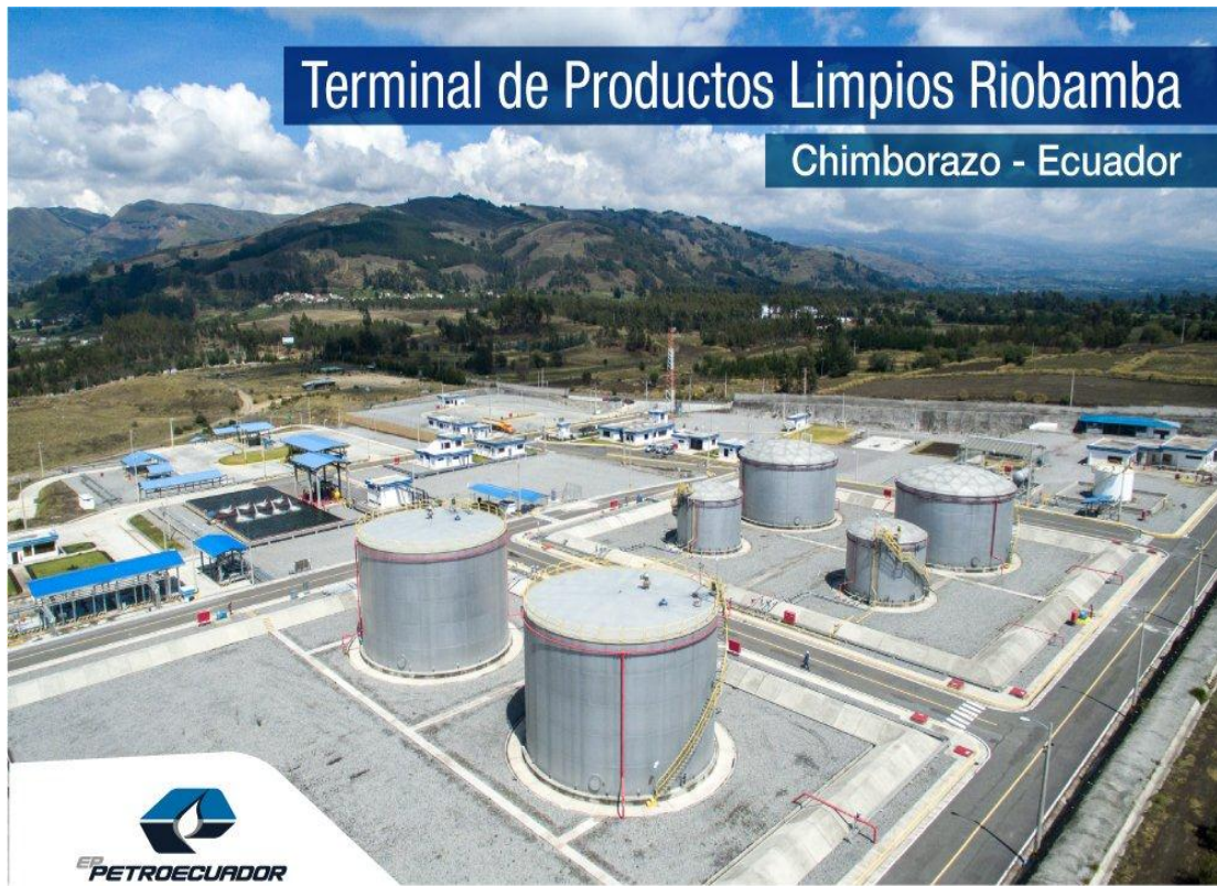
Figura No. 3: Terminal de Productos Limpios Riobamba EP Petroecuador
