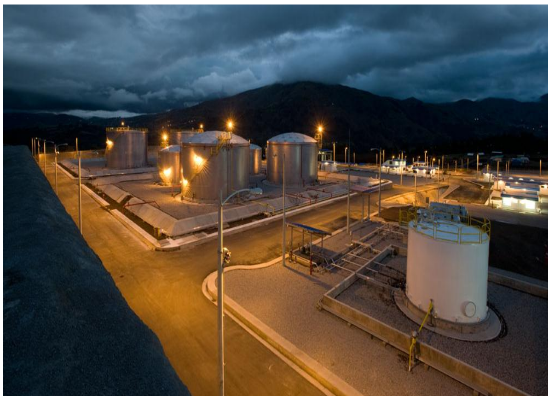
Figura No. 4: Terminal de Productos Limpios Riobamba EP PETROECUADOR
