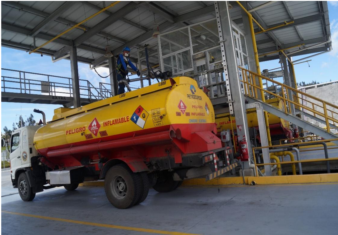
Figura No. 9: Carga de Producto en la Isla del Terminal de Productos Limpios Riobamba EPP
