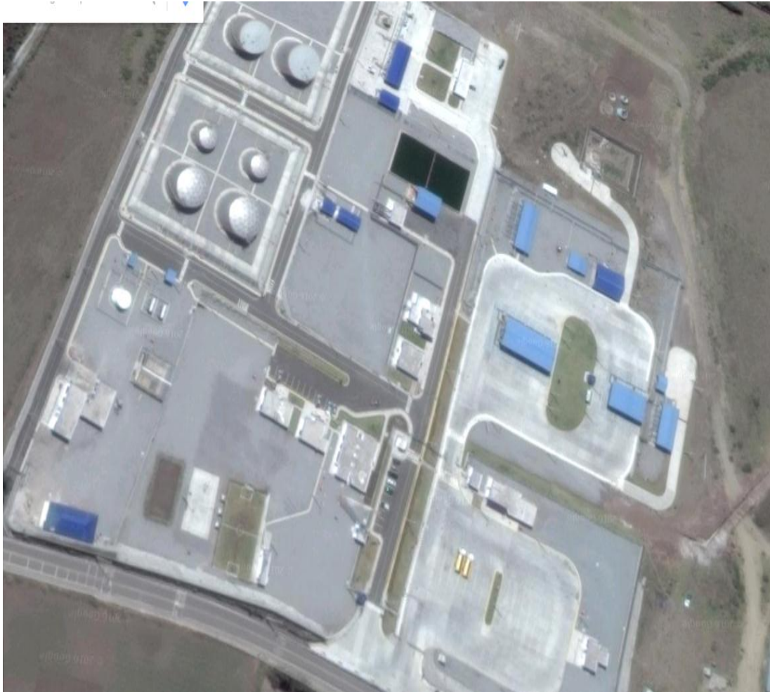
Figura No. 2: Terminal de Productos Limpios Riobamba EP Petroecuador Fuente: Terminal de Productos Limpios Riobamba EP Petroecuador, 2017; (Petroecuador, 2018)
