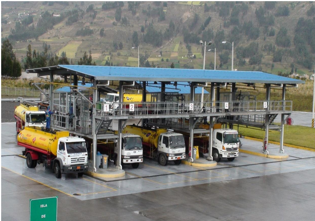
Figura No. 8: Islas de Carga de Combustibles del Terminal de Productos Limpios Riobamba EPP.
