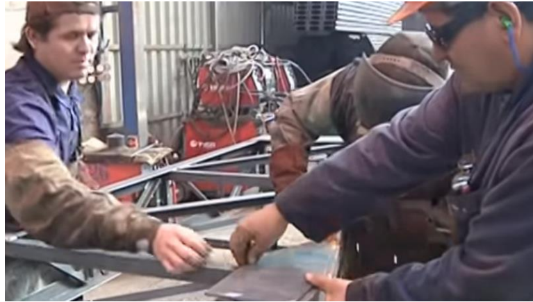
Imagen 9. Procesos de fabricación de estructuras metálicas KG1
