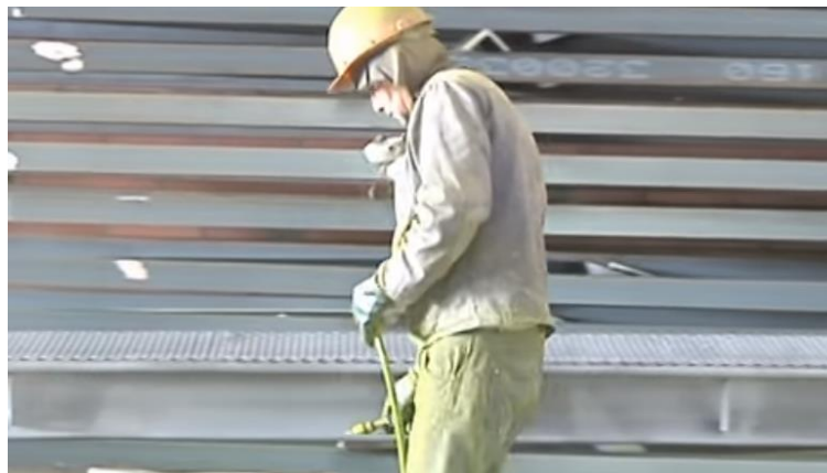
Imagen 8. Procesos de fabricación de estructuras metálicas KG1
