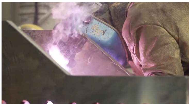
Imagen 6. Procesos de fabricación de estructuras metálicas KG1
