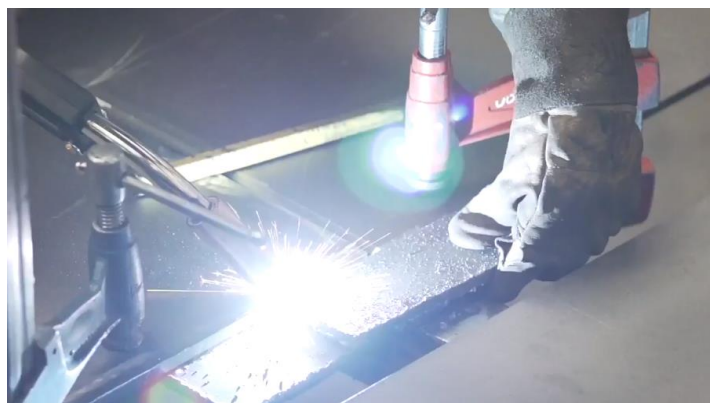
Imagen 5. Procesos de fabricación de estructuras metálicas KG1
