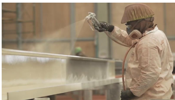
Imagen 10. Procesos de fabricación de estructuras metálicas KG1
