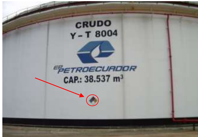
Figura 12 Rombo de seguridad NFPA y su relación de tamaño con el tanque vertical.
