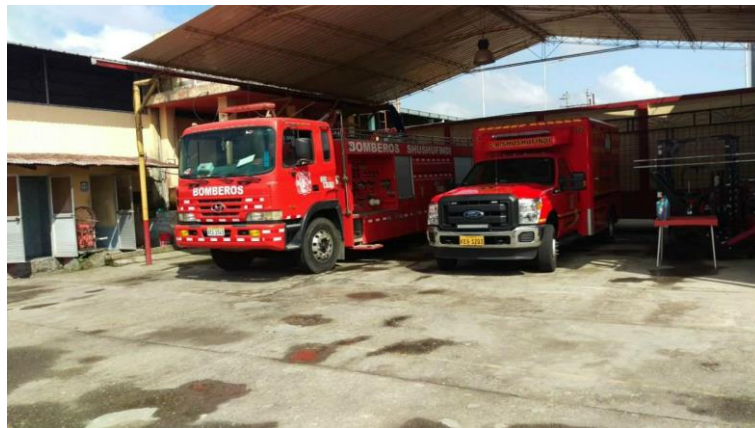
Figura 9: Instalaciones del Cuerpo de Bomberos Shushufindi
