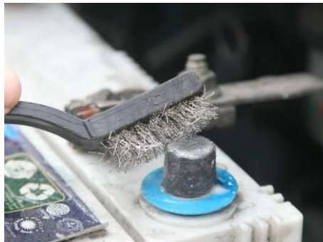
Figura 88: Limpieza de las conexiones de la batería.
