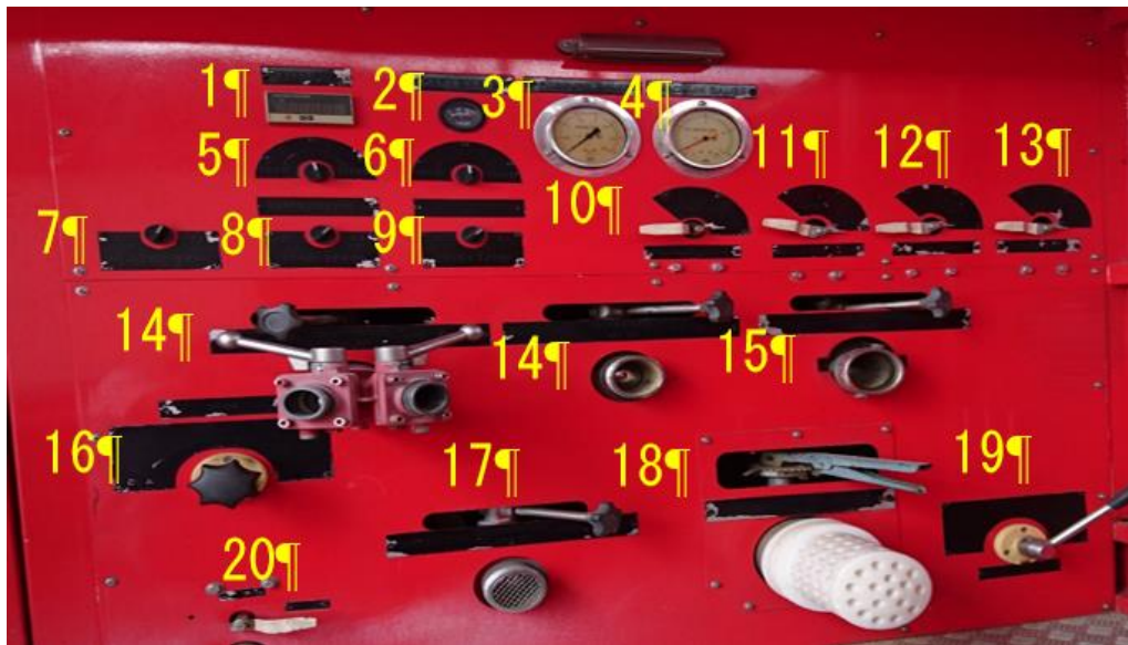
Figura 121: Panel 1 de mandos y manómetros de la bomba Morita
