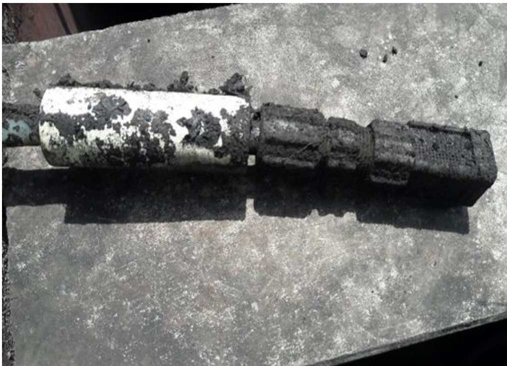
Figura N° 32: Filtro de Dosificador.
