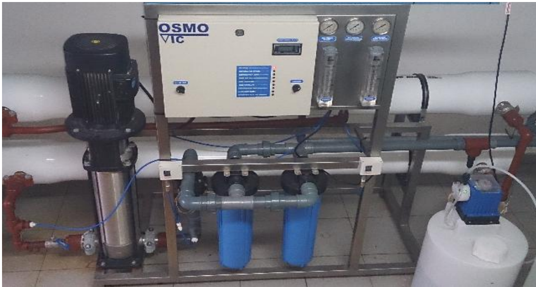
Figura N° 16: Proceso de tratamiento osmosis.
