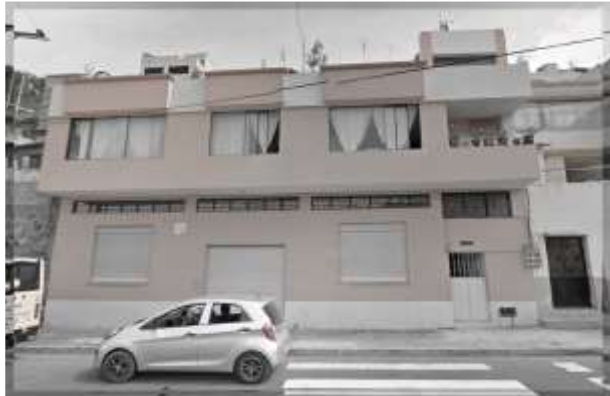
Fotografía 8: Vivienda FR Fuente: Propia
