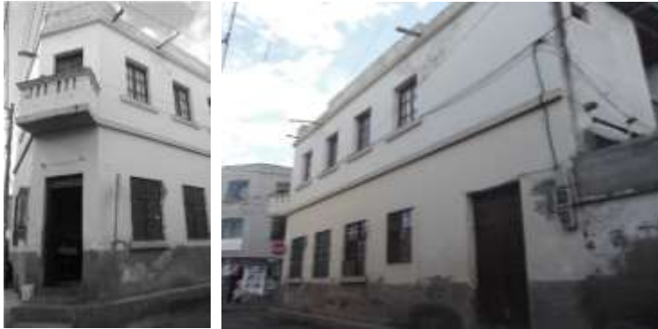
Fotografía 7: Vivienda FR Fuente: Propia
