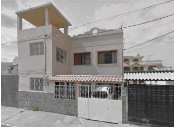
Fotografía 6: Vivienda FR Fuente: Propia
